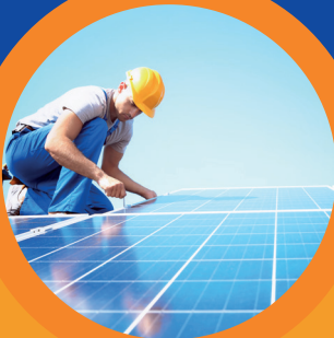
Monteure für PV-Anlagen (m/w/d)
